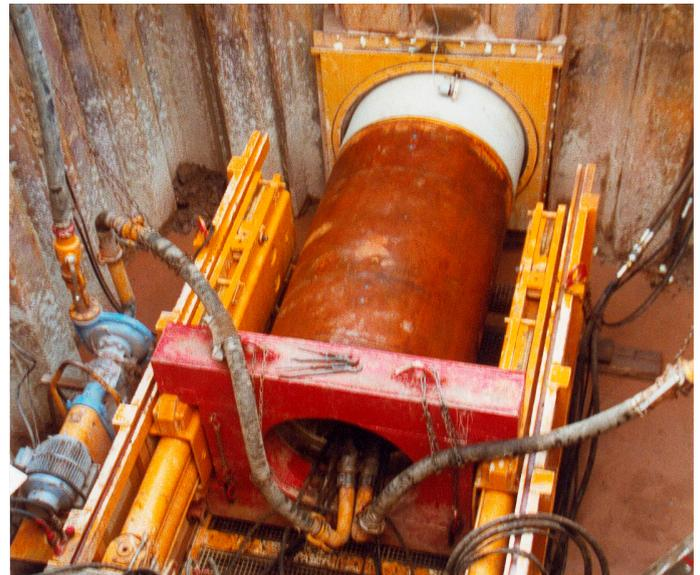
Ansicht des Startschachtes mit Pressrahmen, Förderpumpe, Förderleitung und Speiseleitung
